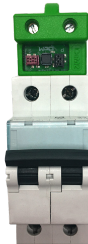
Figure 7 CcM2 instalado en magnetotermico
